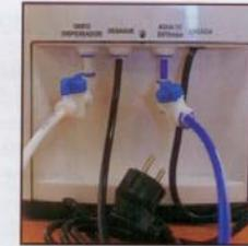
9. Comprobar que la válvula de llenado del depósito está abierta.
